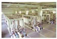
る過膜を使用したものとしては国内最大であり、処理能力は日量6,177立方メートルを誇ります。使用している膜は限外ろ過膜(UF膜)です。
