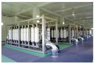
栃木県今市市瀬尾浄水場に納入したもので、計画浄水処理量は1日 14,400立方メートルであり、膜ろ過を使用する浄水場としては国内 最大です。膜ろ過方式は、従来の方式以上の水質が得られ、クリプ トスポリジウムなどの病原性微生物除去に対応可能です。
