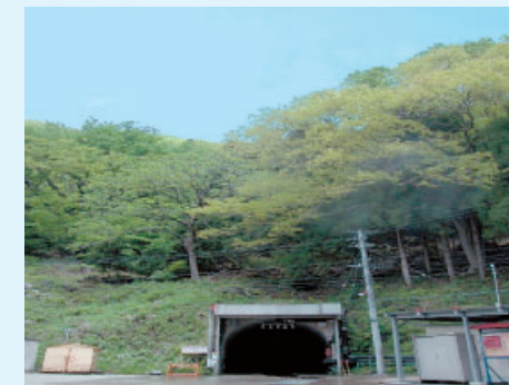
池の山・跡津通洞坑口から車で入山
