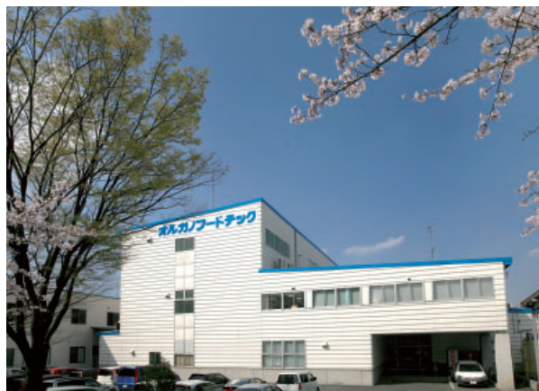
オルガノフードテック社 本社・工場
