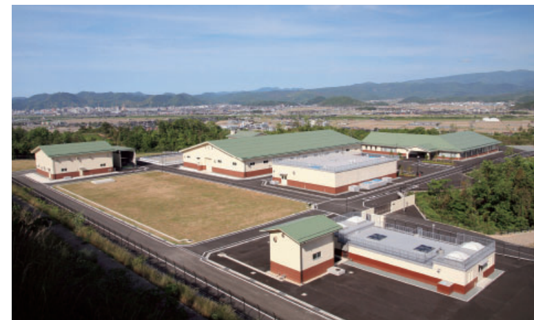
江山浄水場全景
